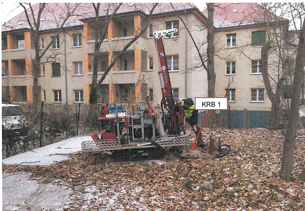
Abbildung 2 Bohrkernsondierung (KRB 1), Blick Richtung Westen.
