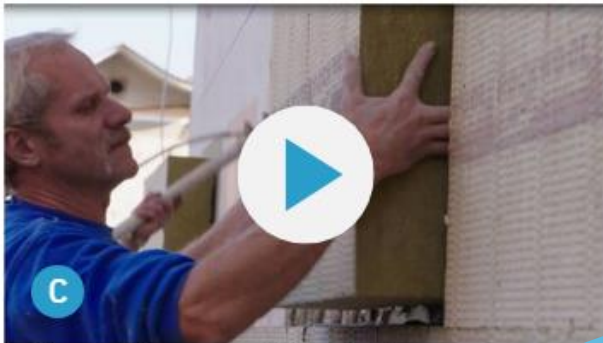
Außenwanddämmung mit Mineralwolle
